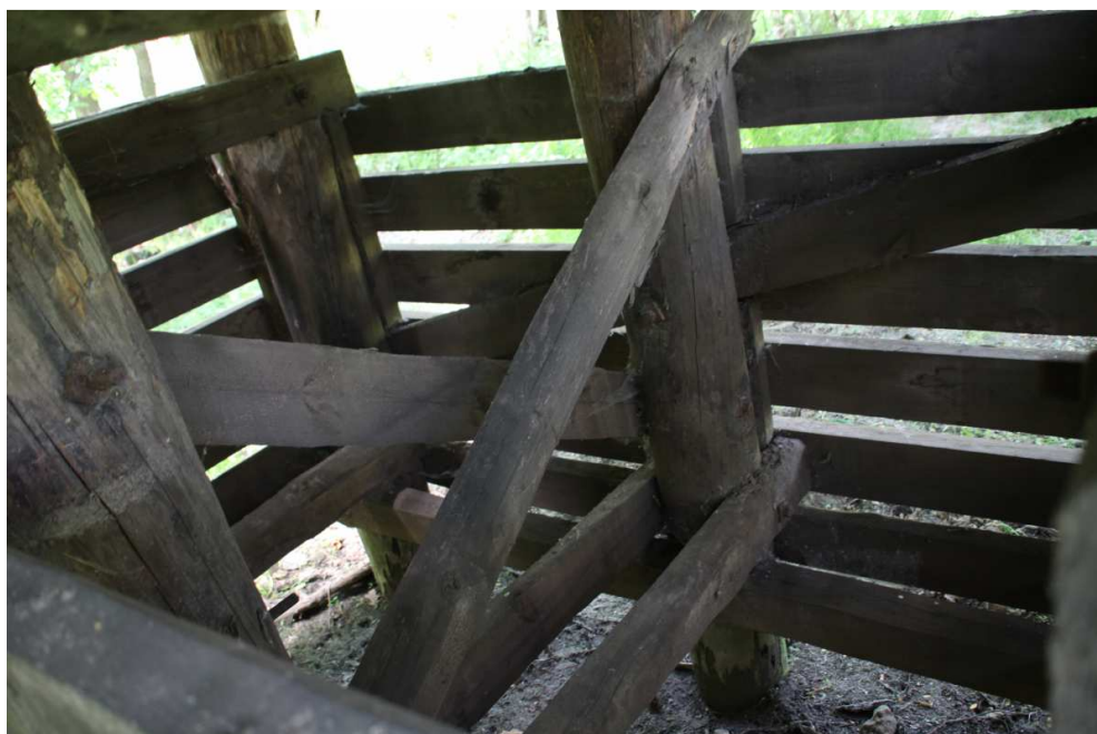
Rys. 4.8. Wnętrze podpory jarzmowej. Zbutwienia pali na poziomie gruntu
