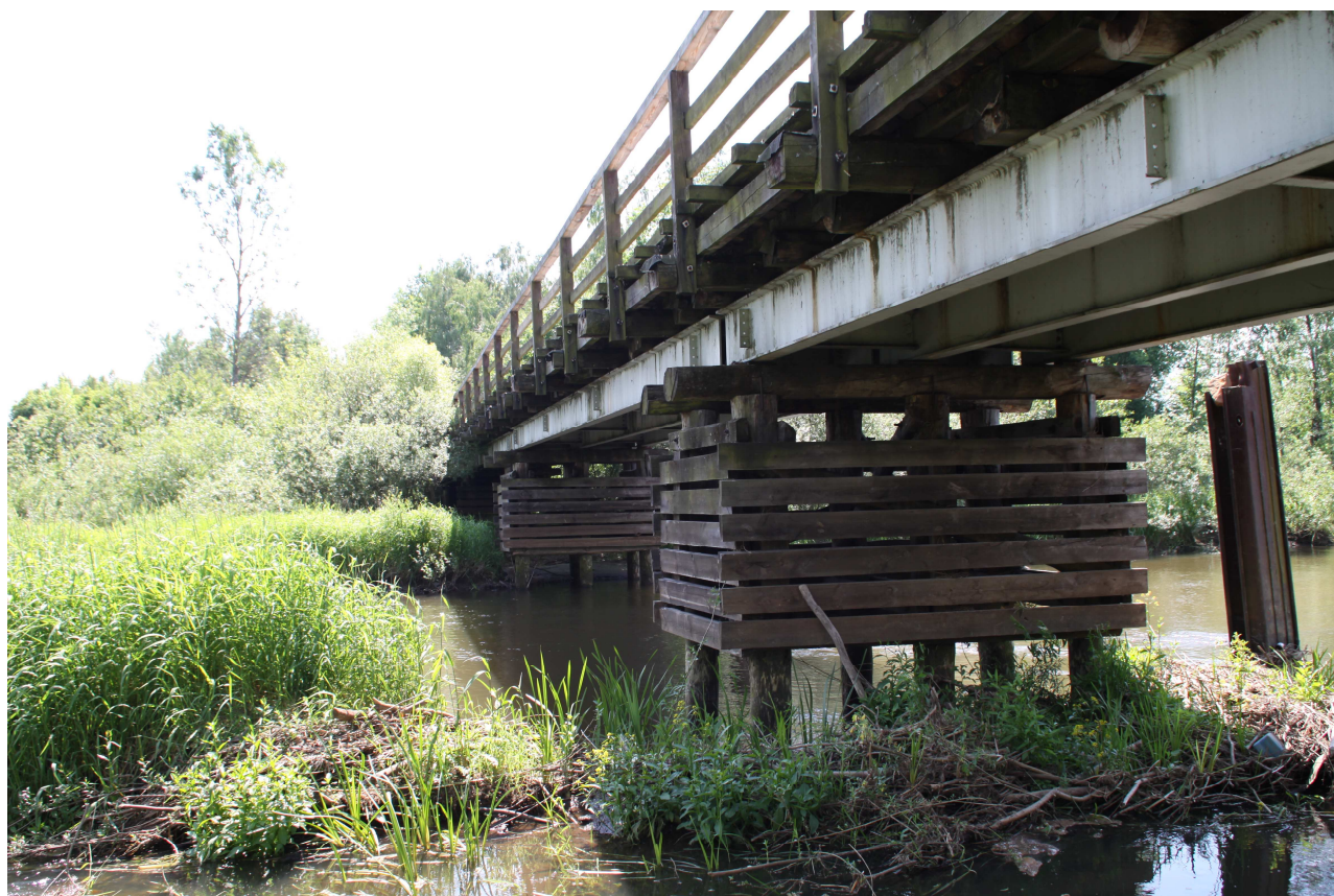
Rys. 2.2. Widok mostu od strony wody dolnej
