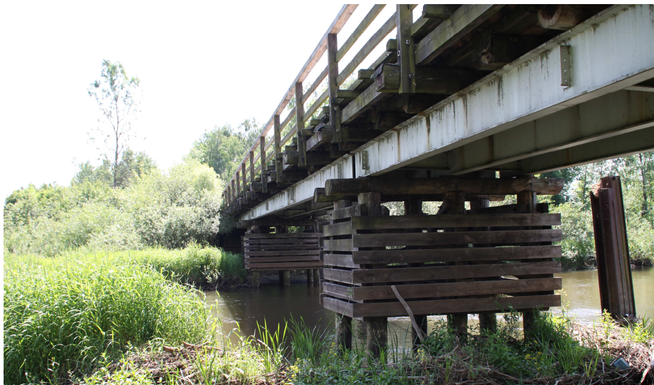
Rys. 2.2. Widok mostu od strony wody dolnej
