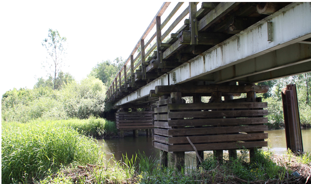
Rys. 2.2. Widok mostu od strony wody dolnej
